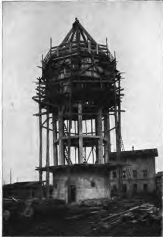
Abb. 29. Wasserturm in Kirchseeon, Oberbayern. Eisenbetongerippe.
